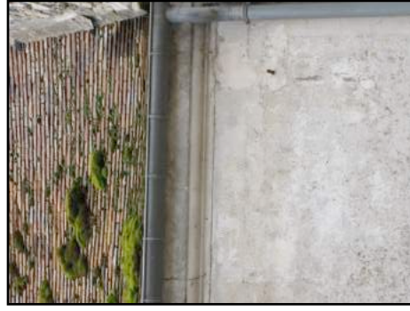
Détail de toiture en petites tuiles traditionnelles d'une grange de la ferme du Bas Montgé, avec façade en plâtre et corniche travaillée. Éléments de patrimoine rural.
